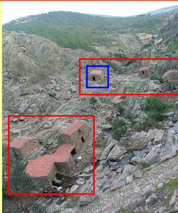
Unidades (caixilhos vermelhos), restauradas, do Complexo Moageiro de Penha Garcia, no vale do Ponsul.
