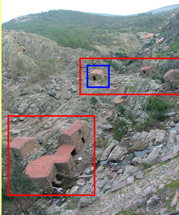
Unidades (caixilhos vermelhos), restauradas, do Complexo Moageiro de Penha Garcia, no vale do Ponsul.
