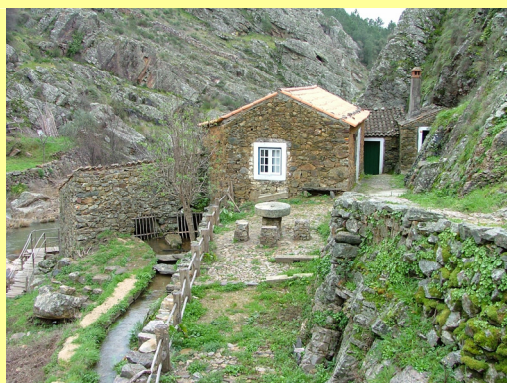
Vista lateral do moinho do Ti Serrano.
